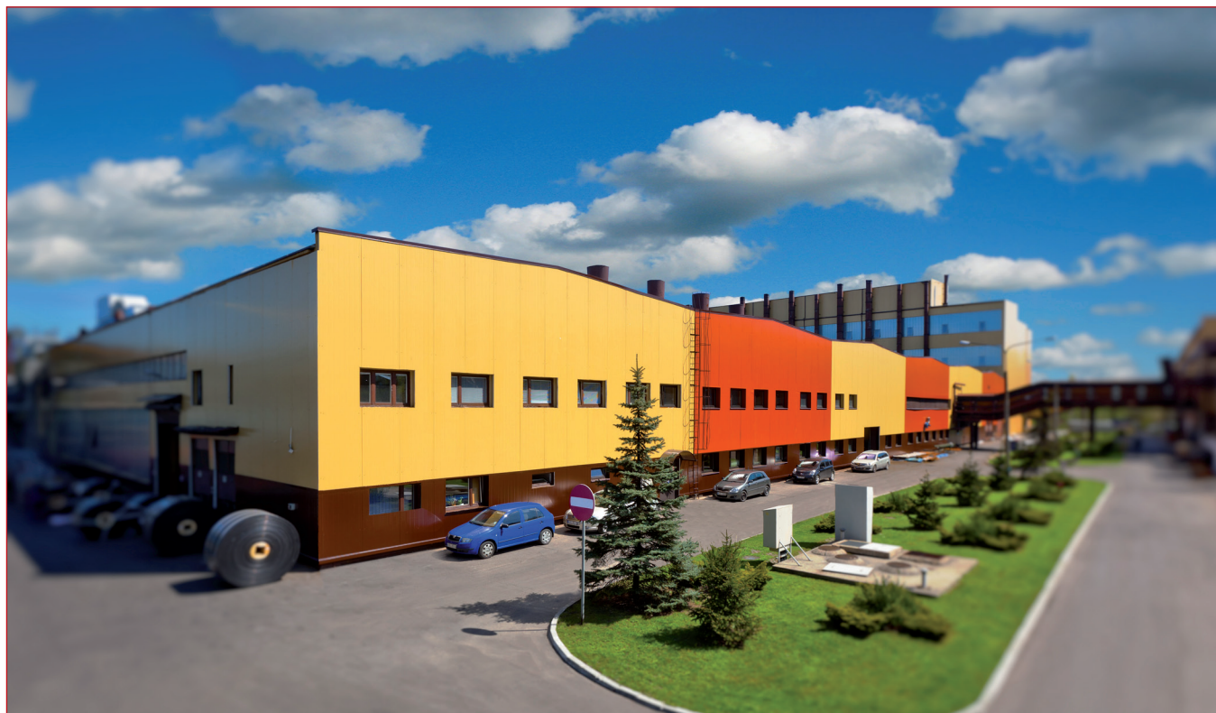
Rys. 1 Hala produkcji taśm transporterowych FTT Wolbrom
